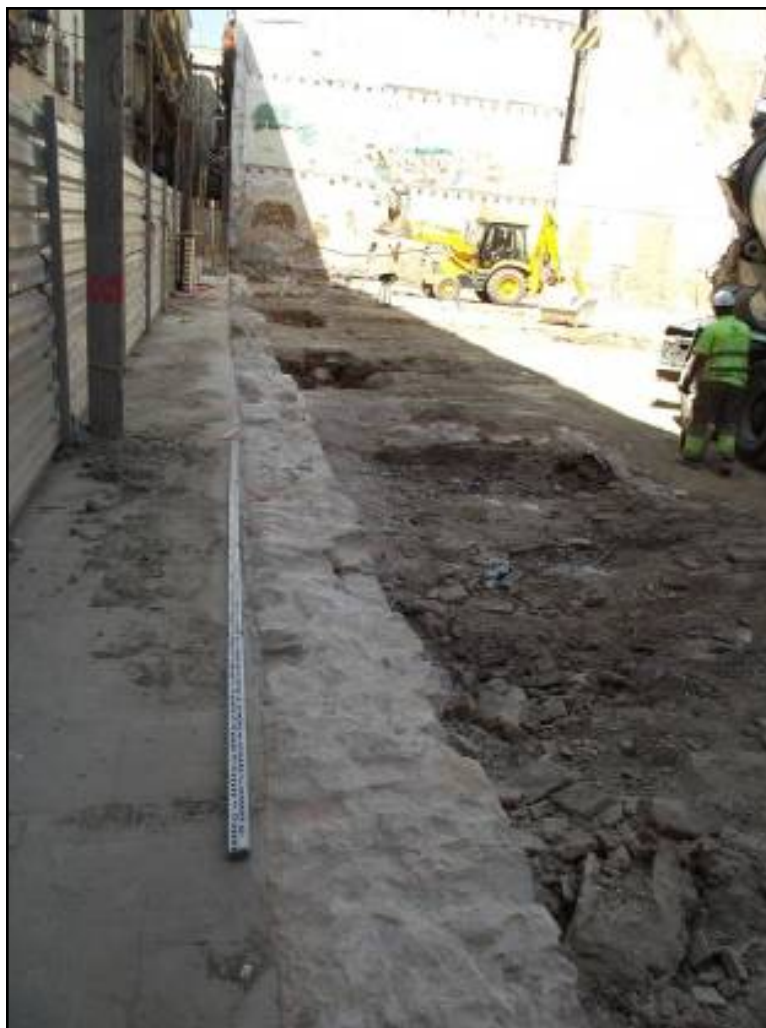
Fotografia 1. Detall de l'extensió del mur de façana del segle XIX U.E.1001
