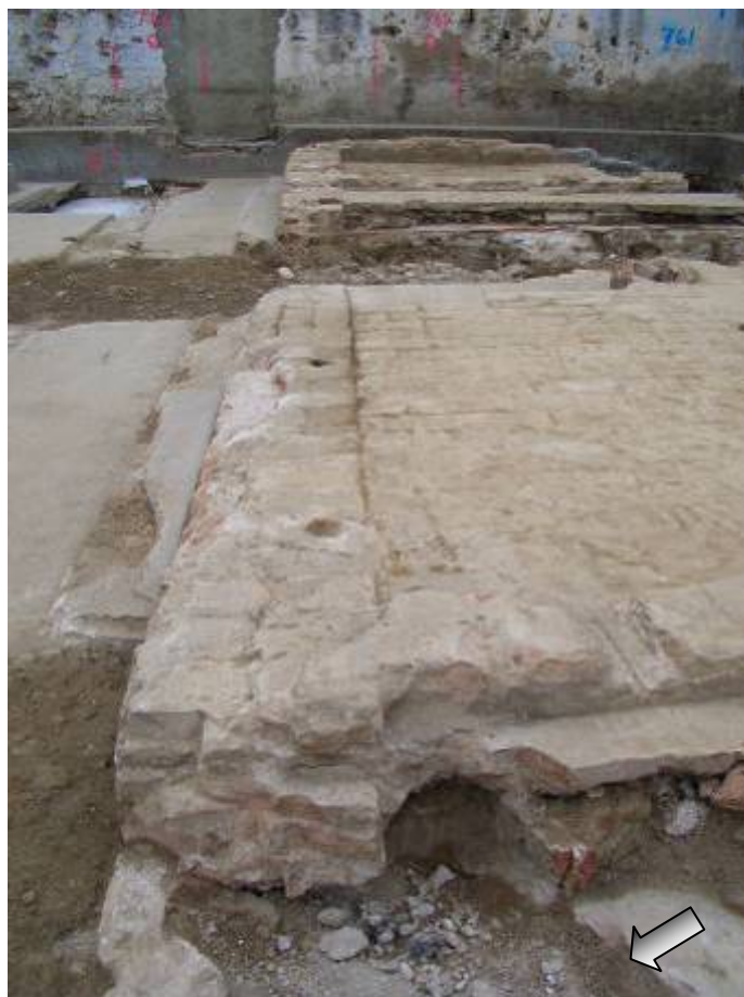
Foto 11: Mur perimetral de les basses 1,2 i 3 (U.E.2023).
