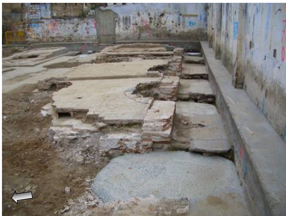
Foto 4: Planxé de ciment a la zona sud. U.E. 2019
