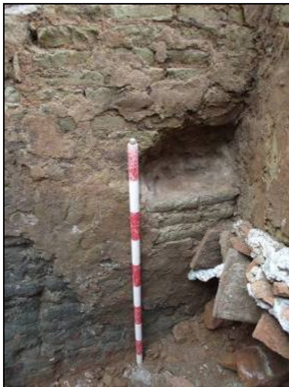
Fotografia 90. Detall dels encaixos laterals a l'entrada de la cambra de combustió.
