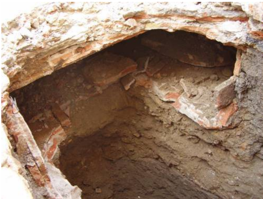
Foto 44: Alçat del dipòsit U.E.2103, localitzat entre les cales 22 i 23.
