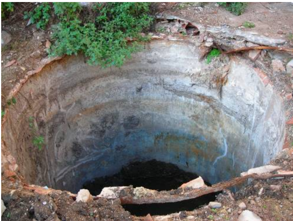
Foto 61: Dipòsit E.E. 2177 reblert amb restes de gasoil i runa
