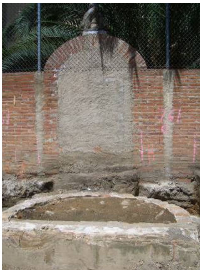
Foto 98: Antiga estructura de la font U.E.2360. I també podem veure l'actual ubicació de la nova font.
