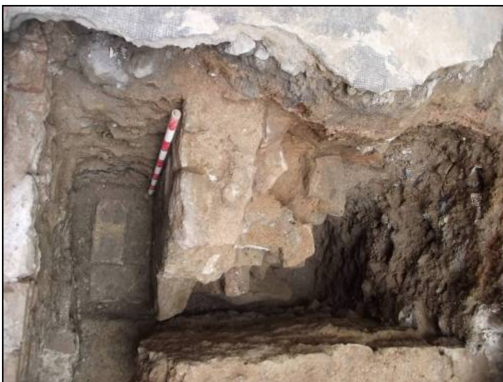
Fotografia 29. Detall des de dalt del dipòsit U.E.1306.
