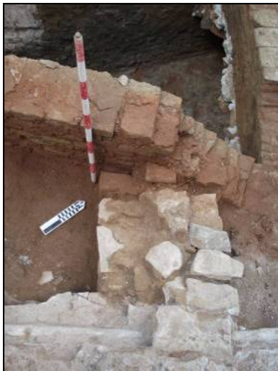
Fotografia 22. Detall del mur U.E.1483.
