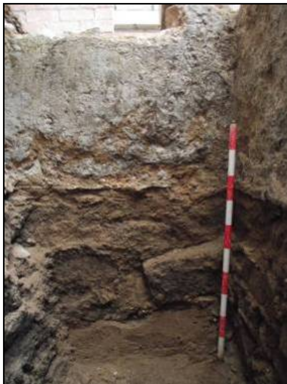
Fotografia 12. Detall frontal del mur U.E.1147.
