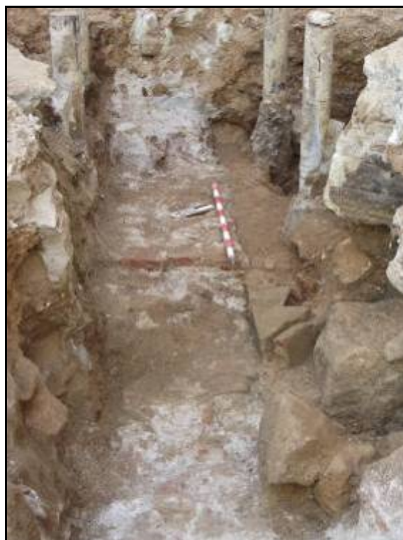
Fotografia 5. Detall longitudinal del mur, del segle, XIX U.E.1116.
