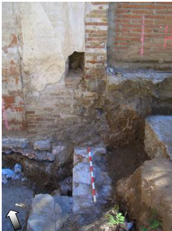
Foto 105: Fonaments del mur U.E.2370, localitzat entre la cala 12 i 13.
