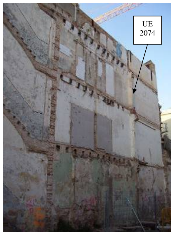
Foto 30: Alçat del mur U.E.2074
