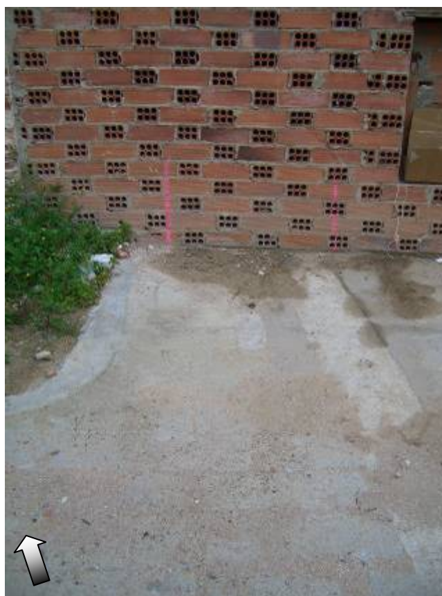
Foto 62: Paviment U.E.2186 que s'extén per la zona NW del solar, entre les cales 6, 7 i 8.
