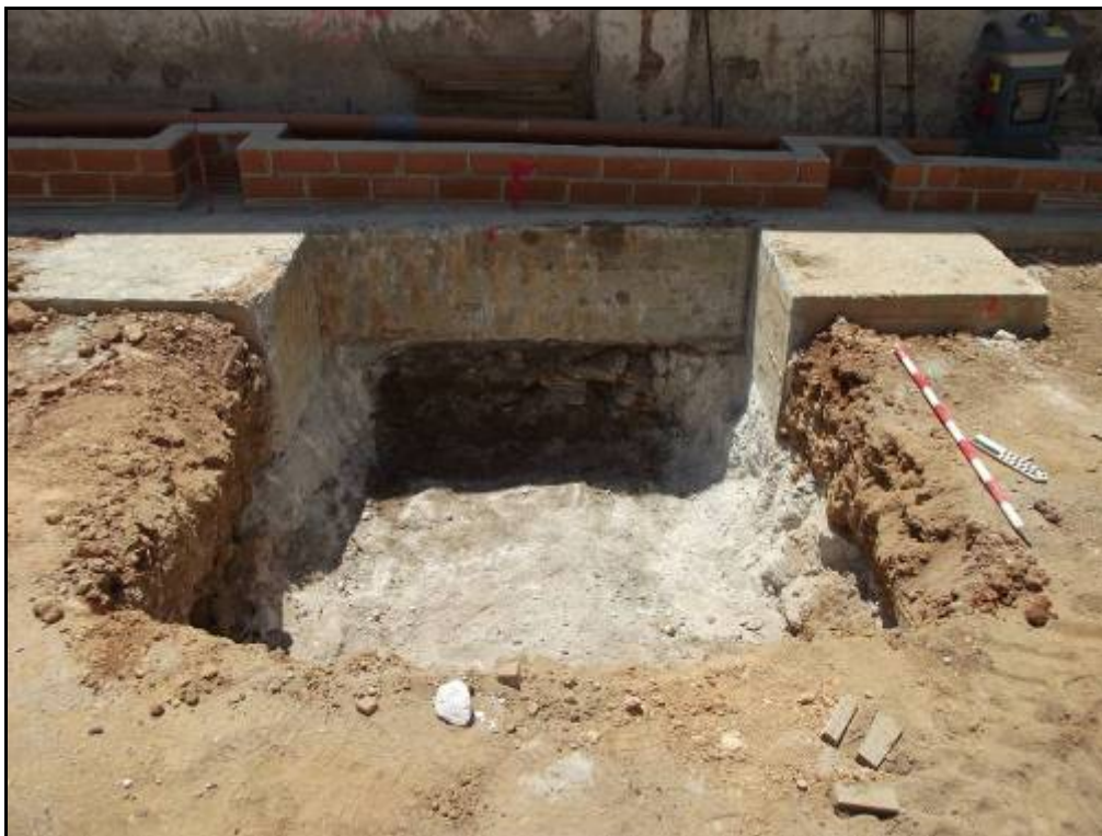
Fotografia 112. Detall del pou B un cop realitzat el buidatge de terres.
